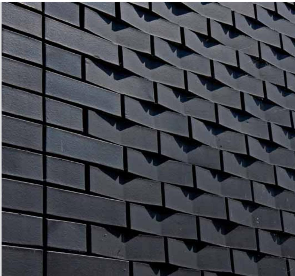
Ansicht von vorne: Schattenklinker ohne Mörtelfuge geklebt
