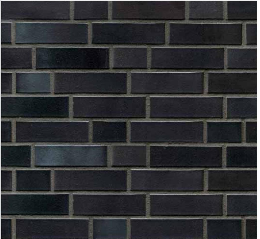
Der Verblendziegel des zweischaligen Mauerwerkes ergänzt sich optimal mit den Materialien Holz und Glas. Der Kohlebrand-Ziegel betont als vorrangiges Baumaterial die Struktur der Gebäude und die dunkle Farbe verleiht ihnen Eleganz und Modernität.
