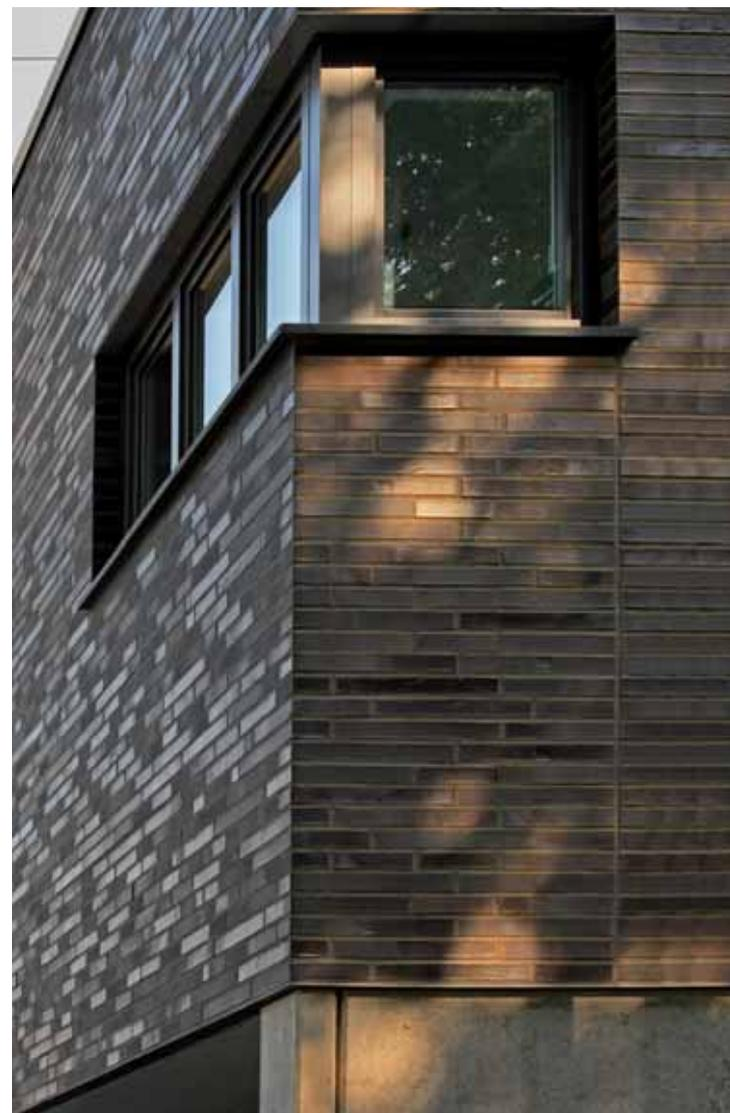
Vermauert wird der Langformatziegel genauso wie ein Ziegel im Normalformat. Aufgrund seiner Länge werden natürlich deutlich weniger Ziegel benötigt. Das spart Arbeitszeit – und reduziert so die Lohnkosten.
